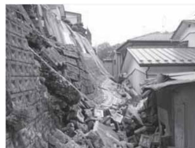
▲施工前（藤倉一丁目）
