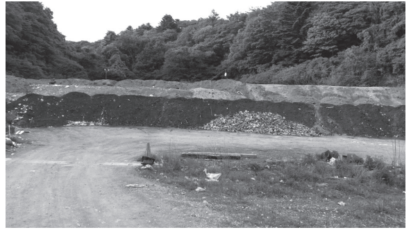
塩竈市廃棄物埋立処分場（利府町）
