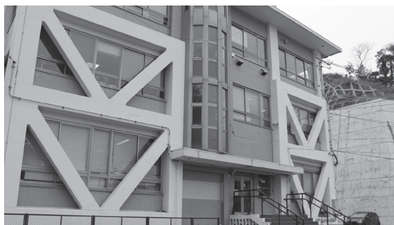
震災直前に耐震補強された本庁舎（東側）
