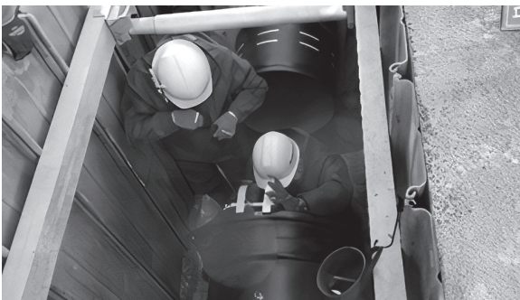
水道管更新工事
