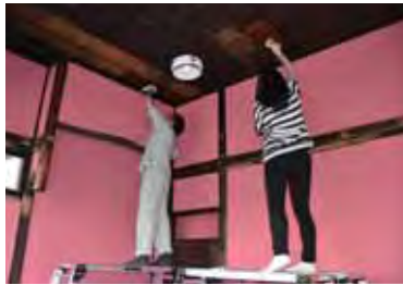
▲蓄積した汚れを拭き取ります
