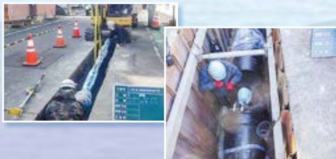
▲ 老朽管更新、配水管整備の様子
