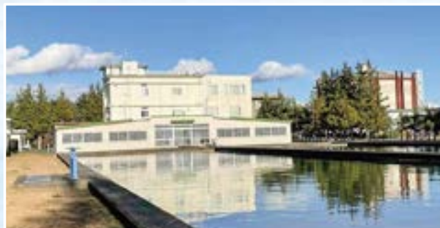
▲ 梅の宮浄水場(稼働から62年経過)
