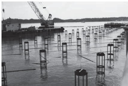
▲県による岸壁復旧工事
