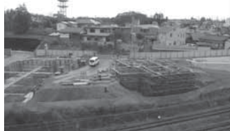
▲2号棟の建設工事現場
