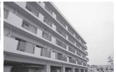
5階建て31戸が入居できる北浜住宅。塩釜港を一望できるのが魅力です。
