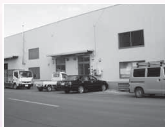
▲現在操業している仮設工場
