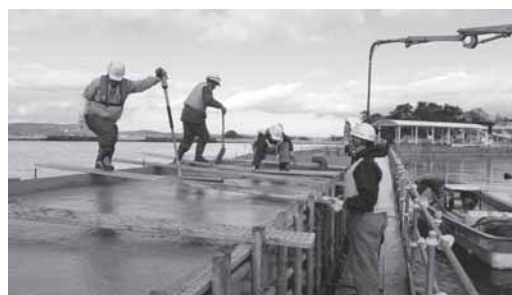
防波堤復旧工事 (野々島)
