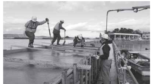
防波堤復旧工事 (野々島)
