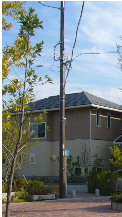
景観に配慮した電柱の事例
