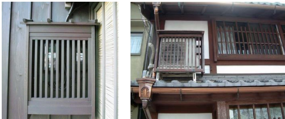
付帯設備の事例
