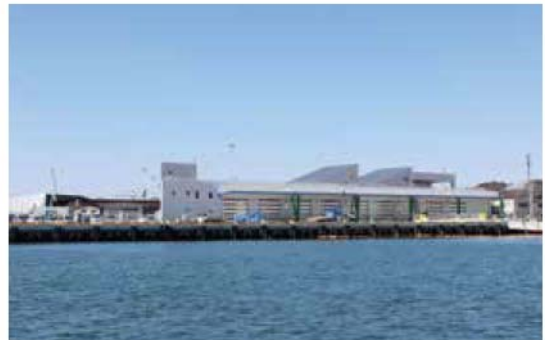
新魚市場（建設中）
