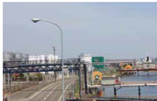
石油配分基地と貞山堀航路（貞山運河）
