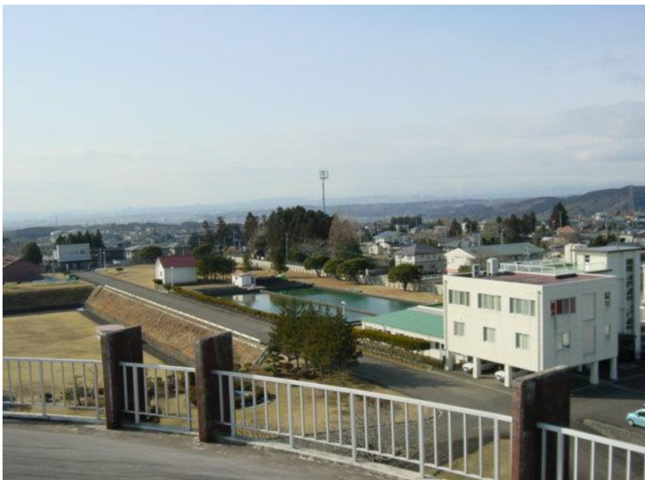
梅の宮浄水場全景
