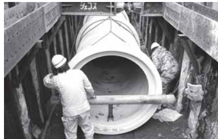
▲雨水管入替工事
