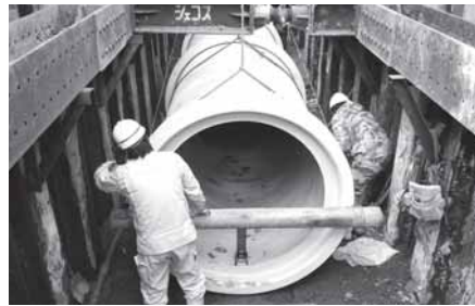
▲雨水管入替工事
