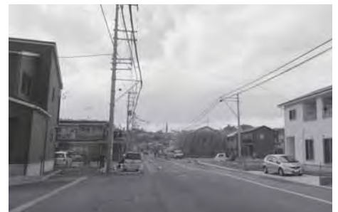
▲道路整備中の区画整理地区(藤倉二丁目地区)
