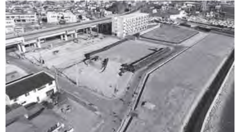
▲宅地造成が進んできた災害公営住宅周辺
