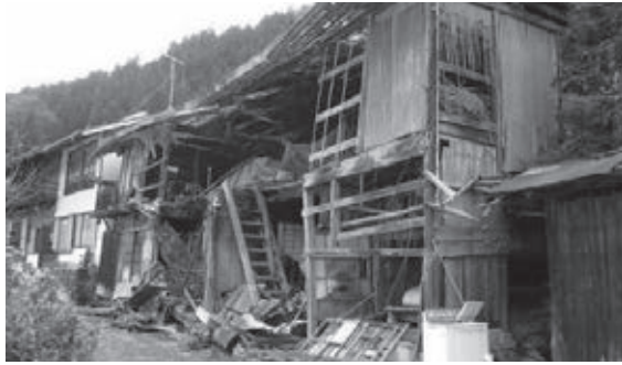
倒壊の恐れのある空き家 (出典:国土交通省「空き家の現状と課題」)
