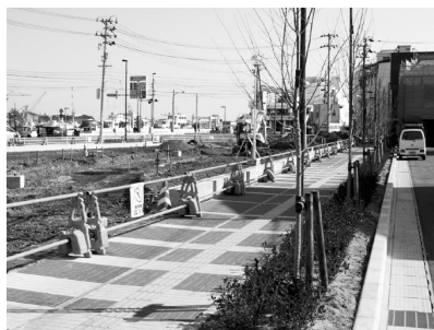
▲まもなく完成する「港町公園」
