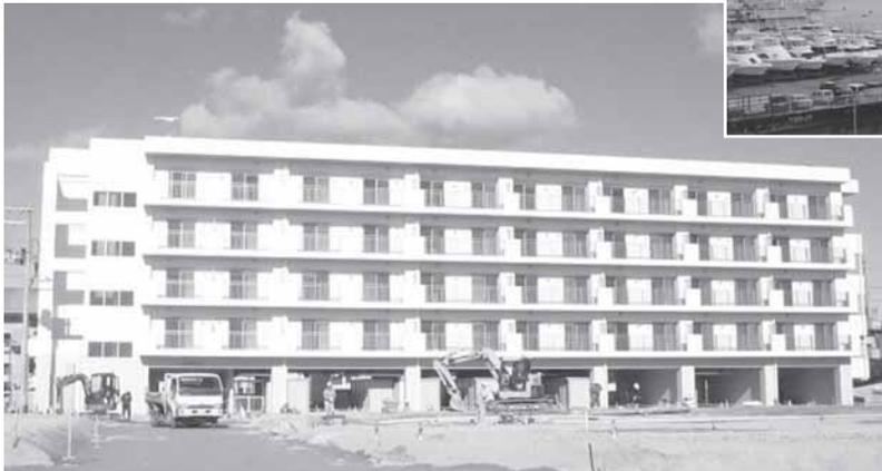
▲現在、内装・外構の工事を進めています。1階部分は柱と壁を残して外部空間としたピロティ形式となる施設です。（5階建て 31戸）
