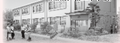
浦戸ステイ・ステーション桂島 (旧浦戸第二小学校)
