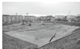
▲貯留槽を埋設（清水沢地区）
