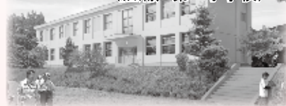
浦戸ステイ・ステーション寒風沢 (旧浦戸第一小学校)
