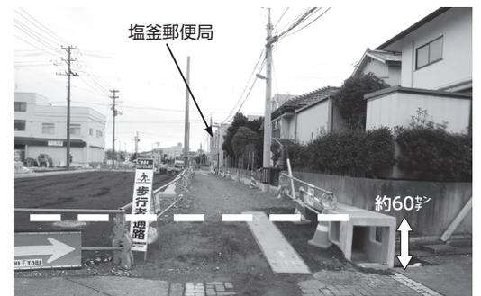
▲側溝が設置された工事箇所。ここでは点線の高さ(約60センチ)までかさ上げされます
