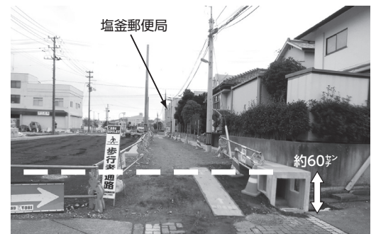
▲側溝が設置された工事箇所。ここでは点線の高さ(約60㌢)までかさ上げされます
