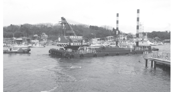
▲盛土材を乗せ出港する搬送船 (七ヶ浜町要害港)
