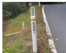
リサイクルの一例、道路のポール（視線誘導標・宮城県）
