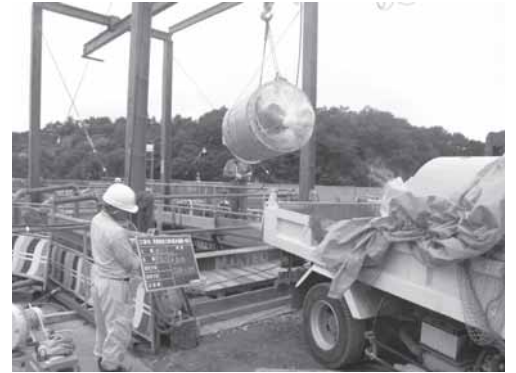
これまで仮復旧の状況だった浦戸石浜～野々島間、野々島～寒風沢間の水道管。県内初の推進工法(海底にトンネルを形成し、水道管を敷設)での工事が完了しました。耐震性が高く、地震災害や津波による水道管への被害が防止され、浦戸地区への安定給水が図られます (寒風沢)
