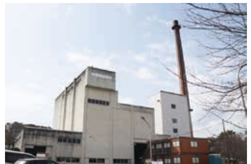
清掃工場の耐震補強工事などを行います
