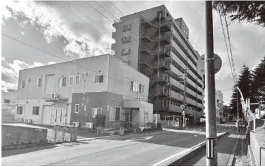
水道窓口移転予定地
