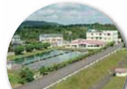
梅の宮浄水場 昭和38年に建設
