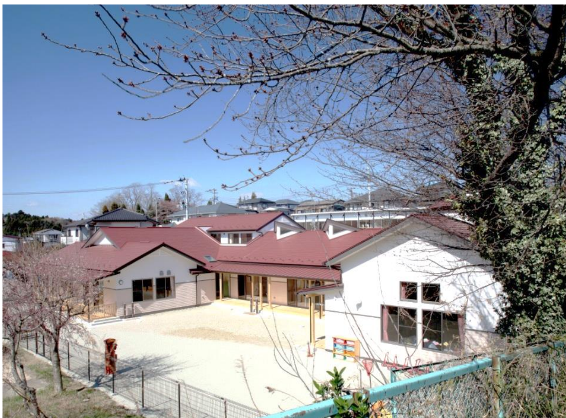
【施設外観】（玉川）
