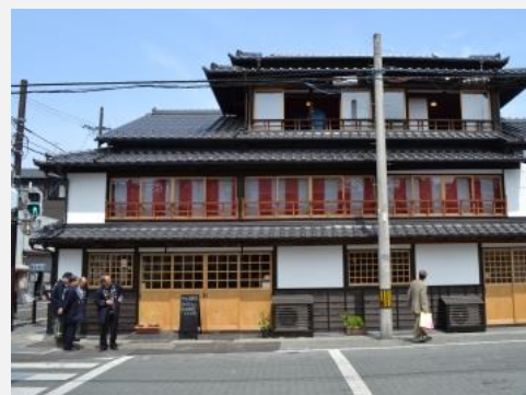
明治初期に建てられた「旧えびや旅館」
