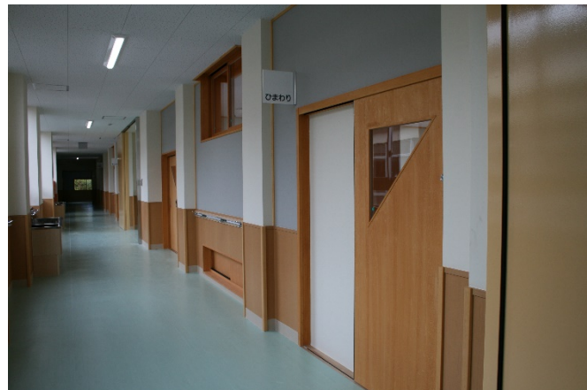
小学校長寿命化改良事業（月見ヶ丘小学校3号棟廊下）
