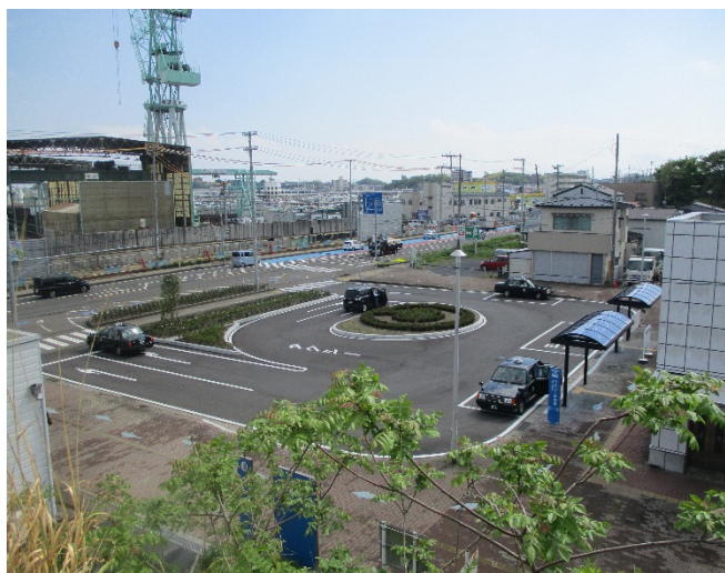
第3期都市再生整備計画事業 (東塩釜駅前ロータリー)
