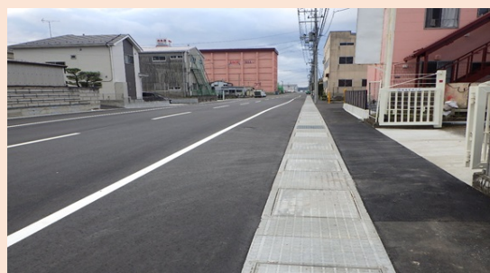
新浜地区漁業集落防災機能強化事業（新浜 2 丁目）
