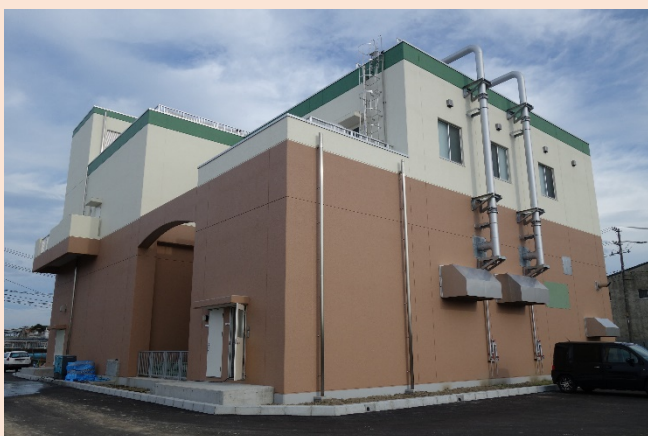
港町二丁目地区下水道整備事業（中央第2ポンプ場）
