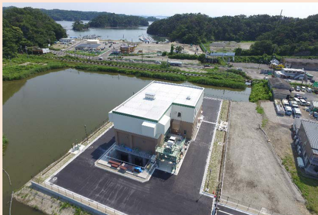
越の浦地区下水道整備事業（越の浦雨水ポンプ場）
