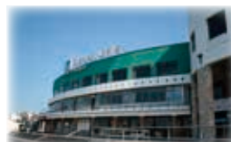
マリンゲート塩釜(屋上)
