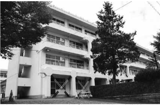
改良工事に向けて調査が行われる第二中学校
