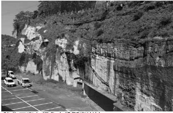
強化工事を行う市役所裏崖地
