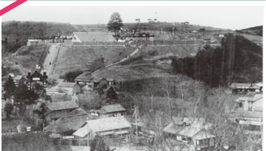
建設当時の権現堂低区浄水場 (現在は稼働はしていません)
