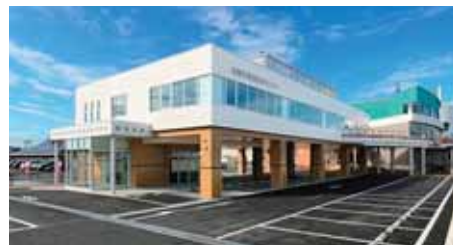
塩竈市津波防災センター
