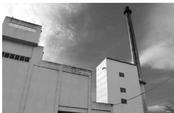
耐震補強設計費などが計上された清掃工場
