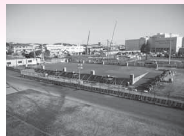
▲仮設荷さばき所整備工事
