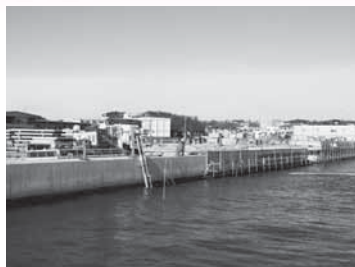
▲漁港施設(棧橋)復旧工事
