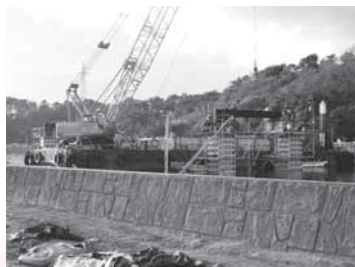
▲寒風沢浮き棧橋復旧工事
