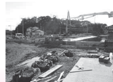
▲野々島船揚場復旧工事
