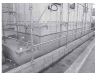
▲本町・高基礎工事 (現状地盤面から50%以上の高基礎)
