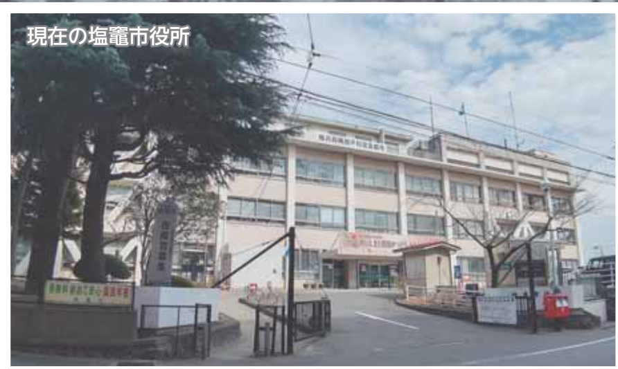
塩竈市役所旧庁舎
