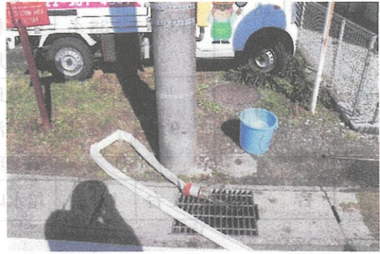
洗管作業 水質確認
