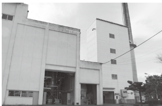
清掃工場 (ごみ焼却場)
