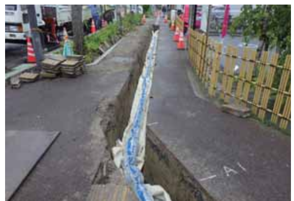
配水管敷設替工事(海岸通地区)
