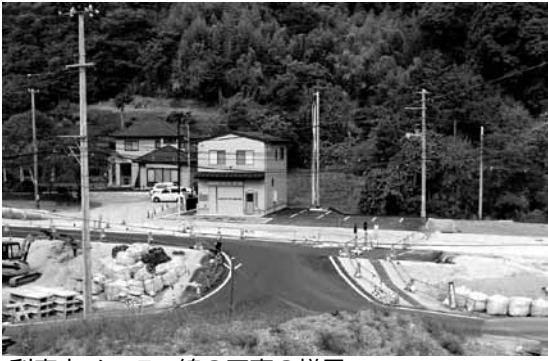
利府中インター線の工事の様子
