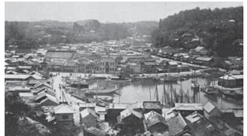
▲明治時代「開港場」と呼ばれた海岸通周辺
