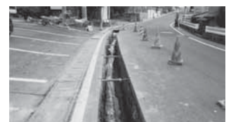
▲老朽化した配水管の敷設工事
