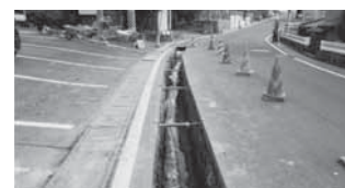
▲老朽化した配水管の敷設工事
