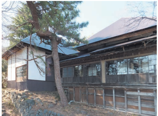
図 55 応急修繕工事完了後の外観
