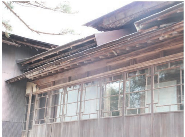
図57 三ノ間屋根（応急修繕工事後）
