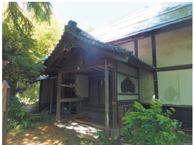
図58 玄関（応急修繕工事前）
