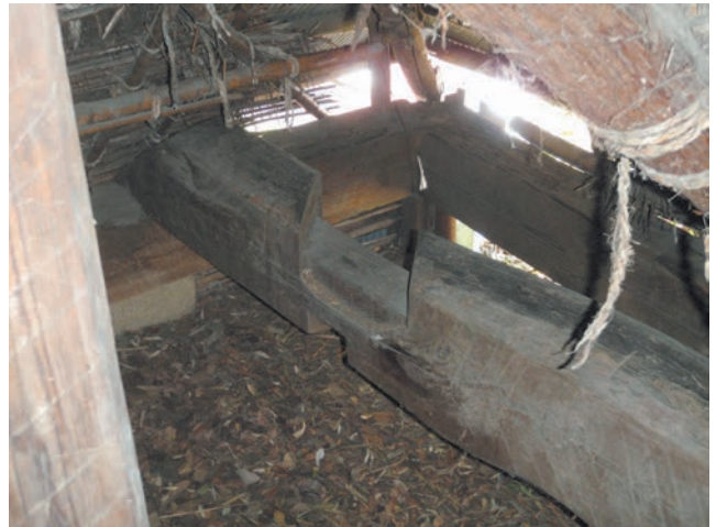
図39 北東隅の隅木痕跡
