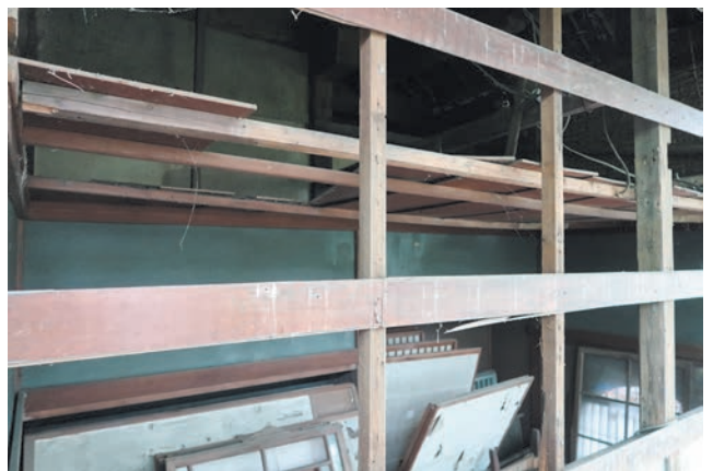
図 51 天井切断痕（詳細）
