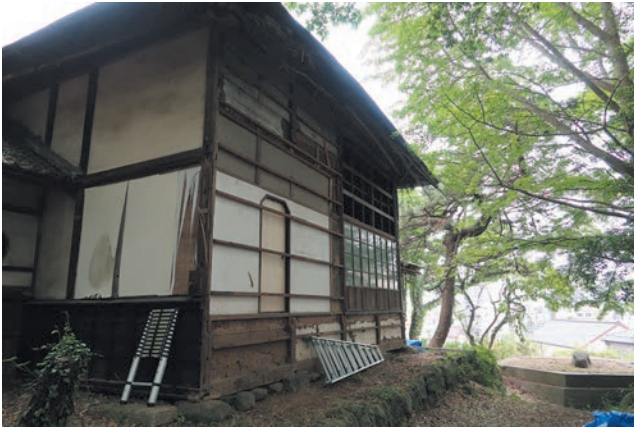
図 46 仮設壁を撤去した南西面
