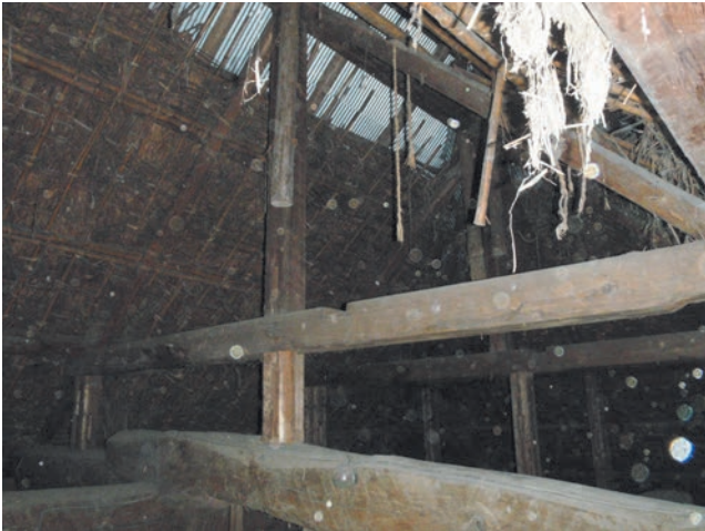
図 40 使用していない仕口跡
