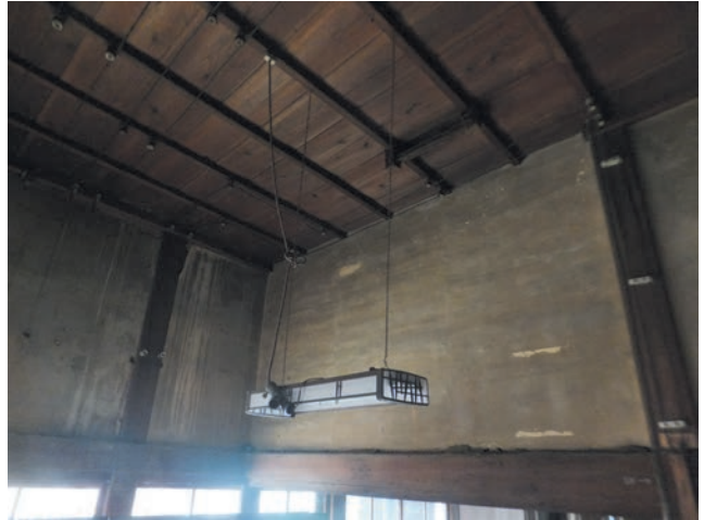
図 41 天井棹縁 (右手の小壁が後補)
