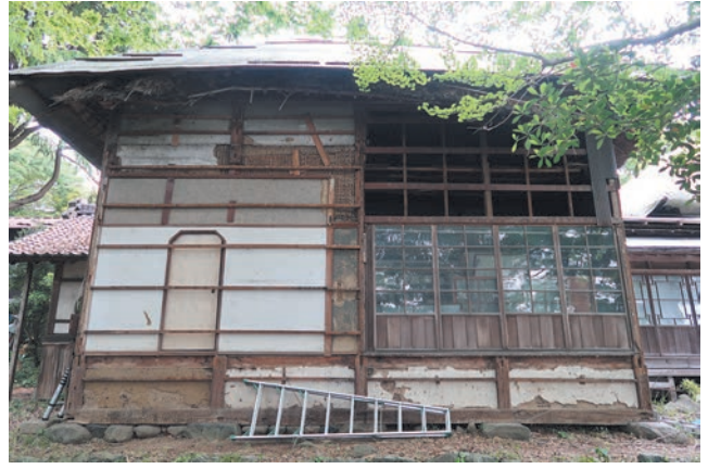
図 47 仮設壁を撤去した南面
