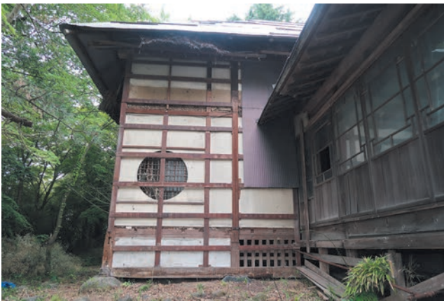
図 48 仮設壁を撤去した東面
