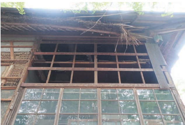
図 50 南面の天井切断痕
