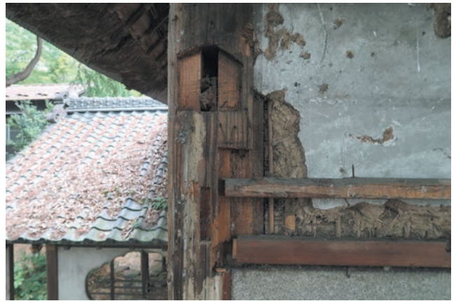
図 49 南西隅柱上部（桁跡）
