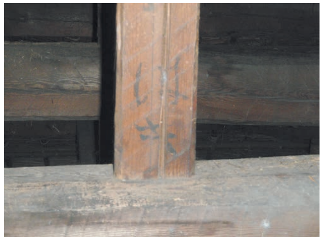
図 28 勝画楼棟小屋裏の番付墨書「はキ」
