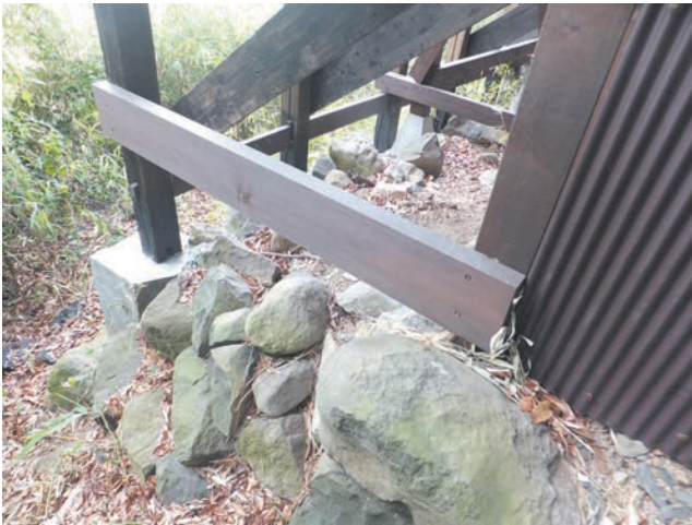
図 23 石積み・束柱修繕箇所 (平成 29 年)
