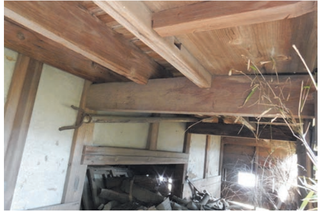
図 19 勝画楼棟縁側床下～段差の下地
