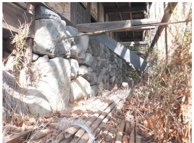
図 22 東側の基壇（玉石積み）
