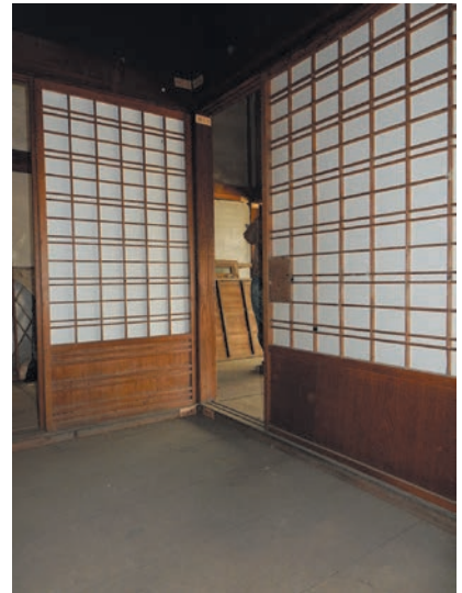
図 29 一ノ間の障子（北東角） 左（北面）：腰・上部とも吹寄せ 右（東面）：上部のみ吹寄せ
