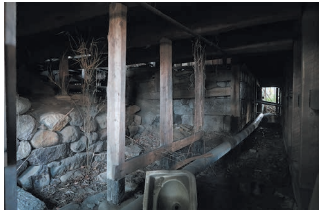
図 21 基壇（玉石積み）
