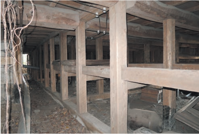
図 18 勝画楼棟の床組
