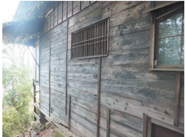
図 24 勝画楼棟北側外壁
