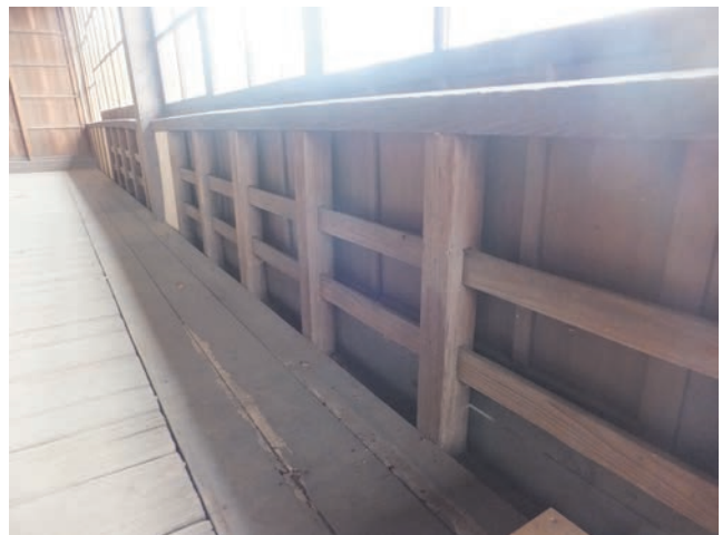
図 32 欄干（勝画楼棟東側）
