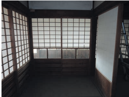
図 30 入側南面の障子（ガラス入り）
