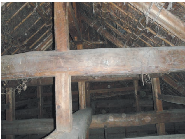
図 27 勝画楼棟小屋裏
