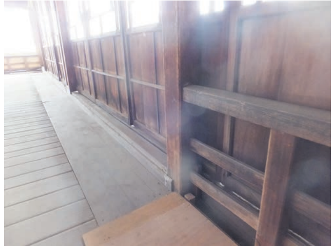
図 33 取り外された欄干部
