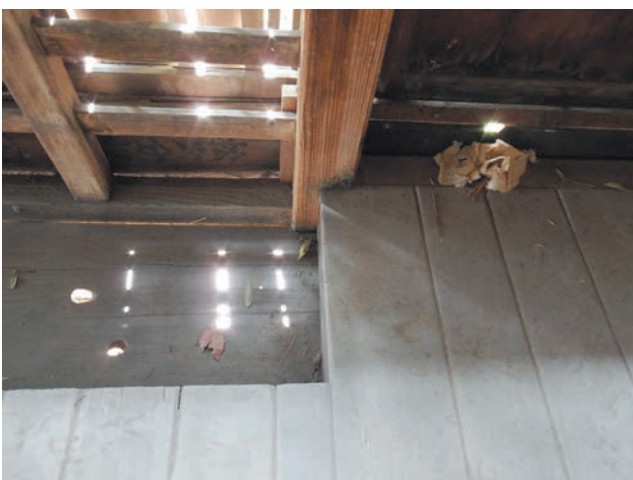
図 31 縁側（切目縁と落縁）
