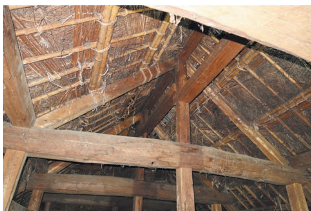
図5 勝画楼棟の小屋裏の状況
