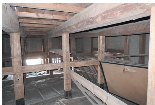
図6 勝画楼棟の床下の状況
