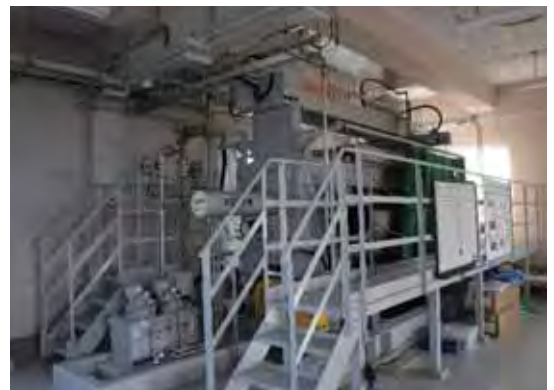
▲梅の宮浄水場加圧式脱水機
