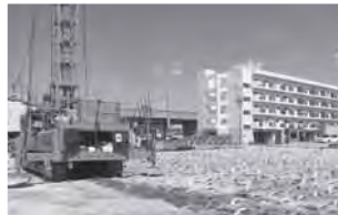
▲大型重機で地盤補強工事を進めています
